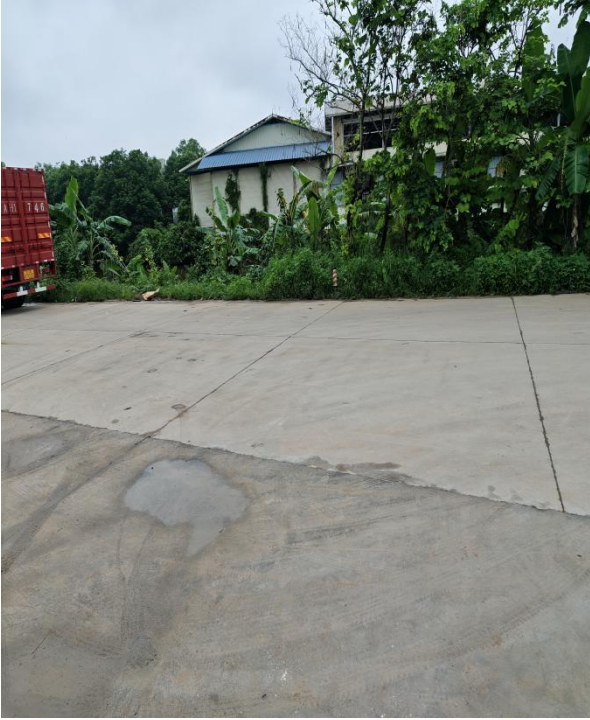
场地东北侧市政道路
